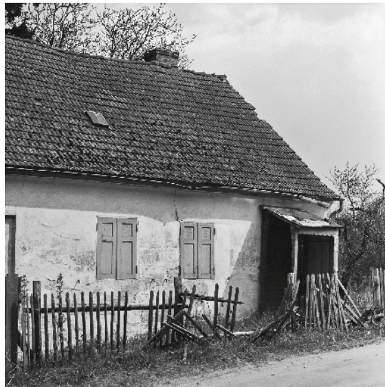
Altes Haus in Ferch- Junkershäuser
