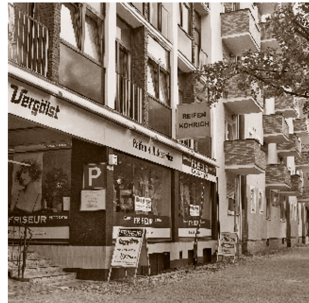
Neubau in der Kaiser-Friedrich-Str. 70, 2010
